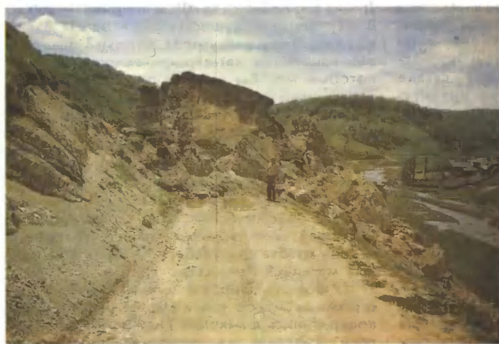
Разрушения, причиненные одним из крупных оползней, возникших в результате Рачинского землетрясения. Хорошо различимы также трещины в грунте.
