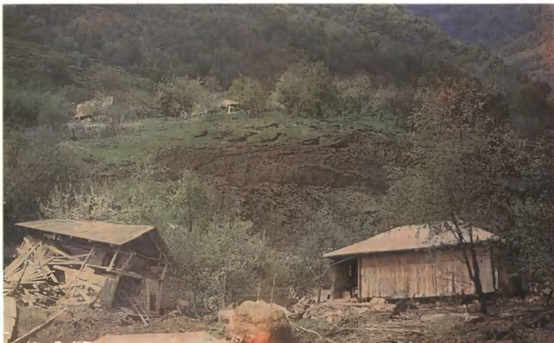
Разрушения, причиненные одним из крупных оползней, возникших в результате Рачинского землетрясения. Хорошо различимы также трещины в грунте.
